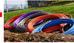
Cable de Fibra Óptica
